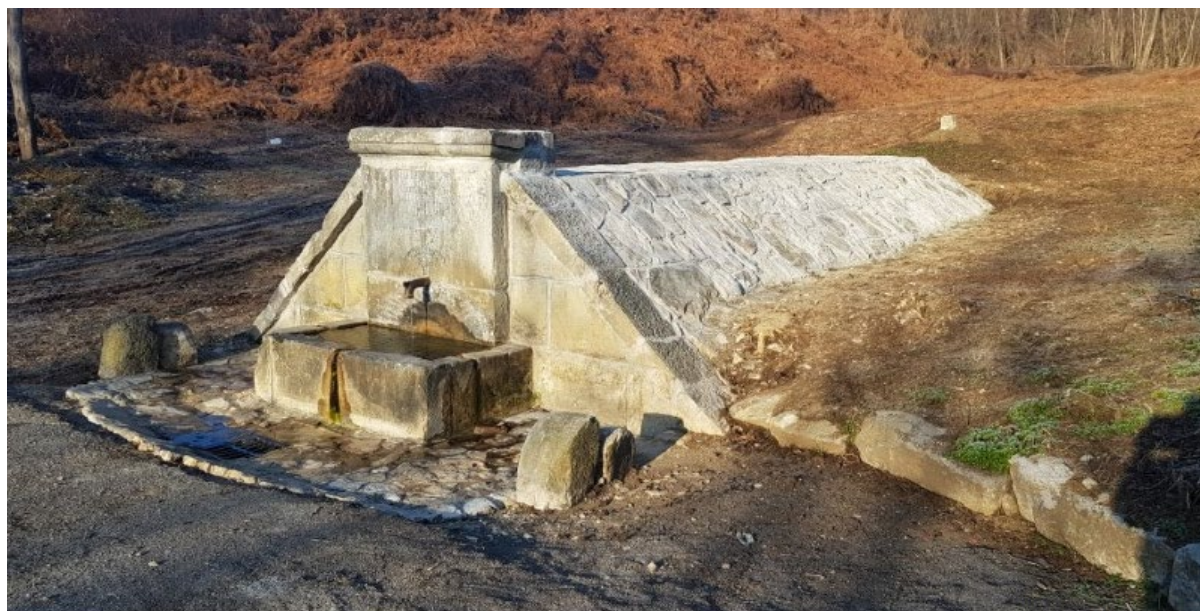
F.4., F.5. Kameni most preko rijeke Tounjčice, Božidar vrelo u Potoku Tounjskom uz trasu Jozefinske ceste (B. Križanić, I. Sopek 2018.)
